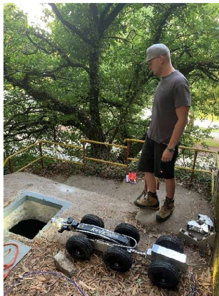
1. Öffnung nahe Zulauf 9m tief
