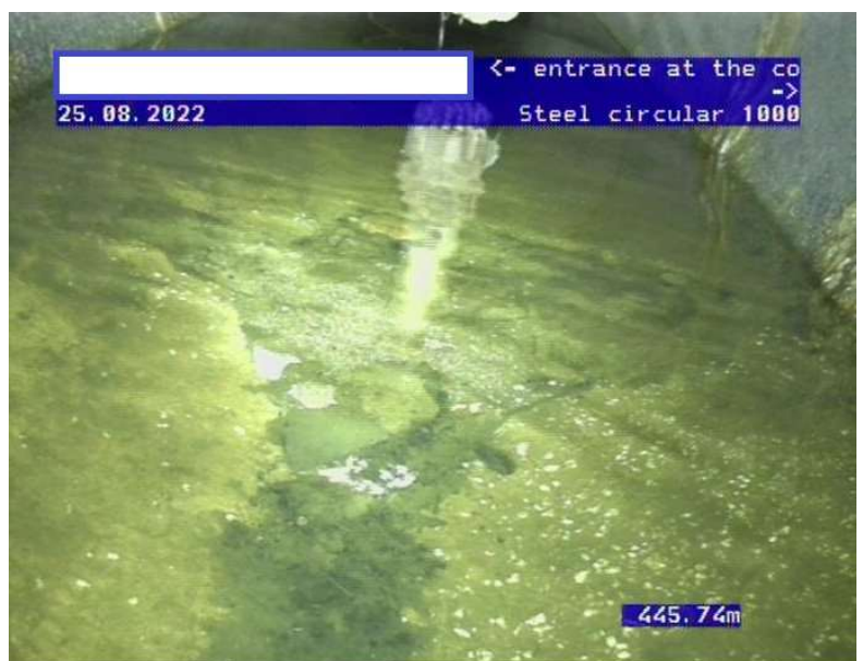
Großer Rohrbruch in der Sohle
