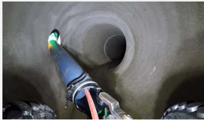
Inspektion im DN900 Hauptkanal in DN150 Anschlussleitung
