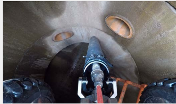
Einsetzen in Schacht ø600mm
